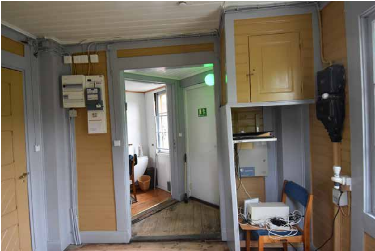
Sakristian efter avslutade målningsåtgärder. Vy mot väster. Elinstallationerna till vänster i bild kan eventuellt döljas av ett draperi. Den sneda skivväggen under överskåpet kan med fördel bytas ut mot en brädvägg av pärlspont.
