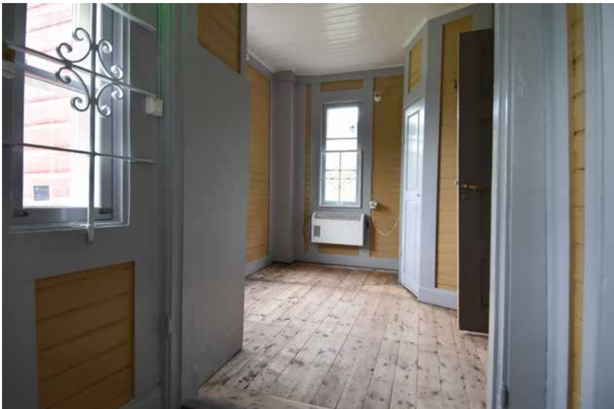
Förrum (hall) och sakristia efter avslutade åtgärder.
