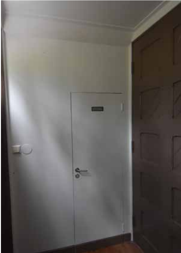
Vapenhus efter avslutade målningsåtgärder, vy mot norr.
