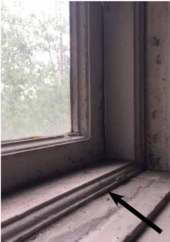
Detalj från sakristian. T.v, pilen visar anslaget före den planerade innerbågen. T.h Förslag på anslagslist som ger en större anslagsyta mot en innerbåge.
